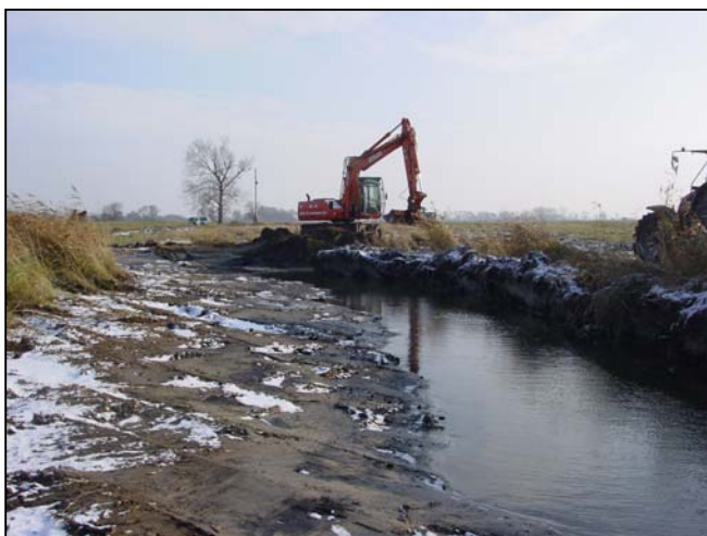
Anlage von Senken auf der Maßnahmenfläche
