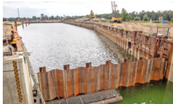
400 Meter lange Umschließung der Baugrube
