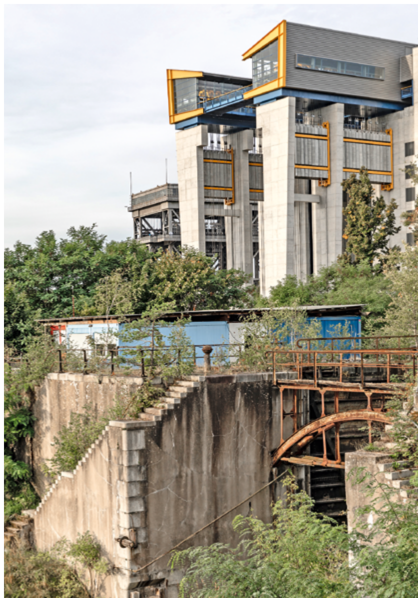
Neben den Resten der Schleusentreppe erhebt sich das neue Schiffshebewerk
