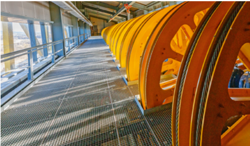
Blick in die Seilscheibenhalle des neuen Schiffshebewerks
