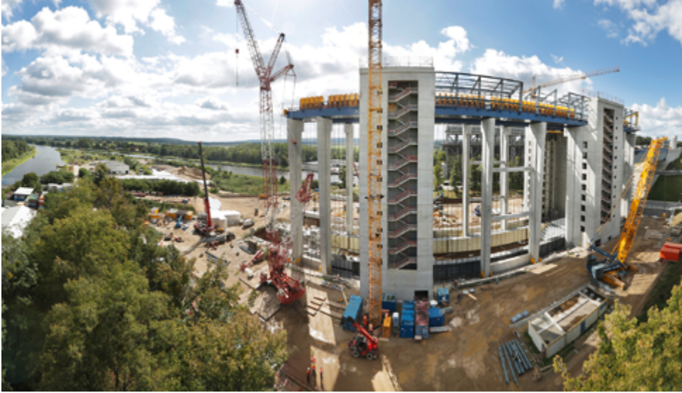
Neues Schiffshebewerk in der Bauphase
