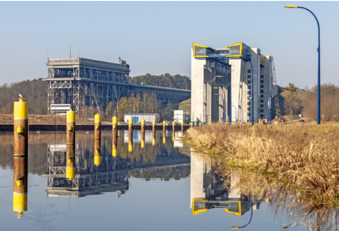
Altes und neues Schiffshebewerk Niederfinow
