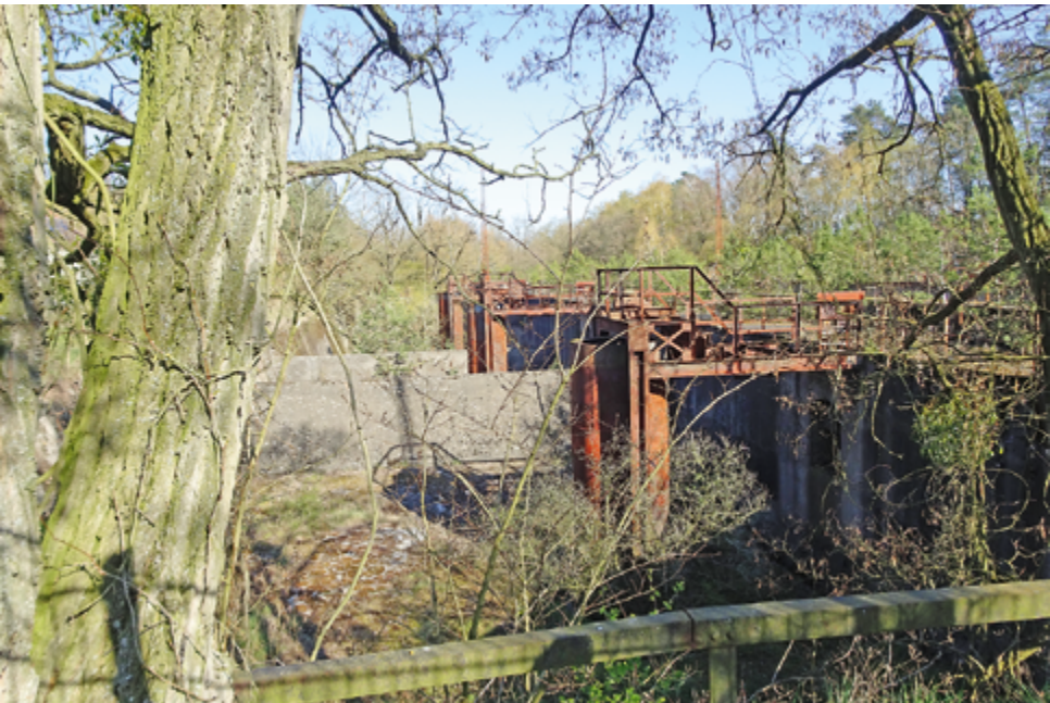
Zuwachsende Schleuse der alten Schleusentreppe
