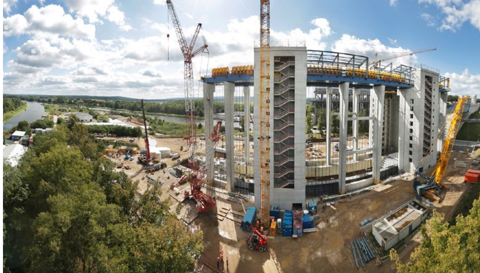
Nowa podnośnia statków podczas budowy
