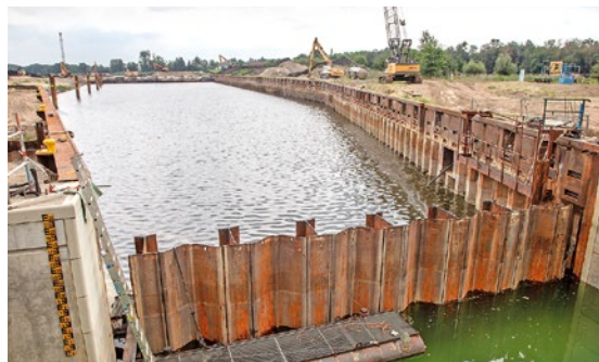
400-metrowe obudowanie wykopu
