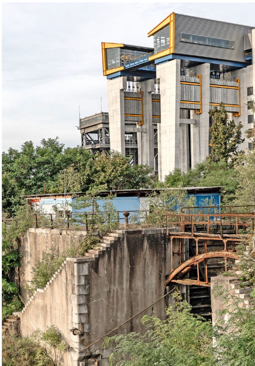
Obok pozostałości schodów śluzu wznosi się nowa podnośnia statków
