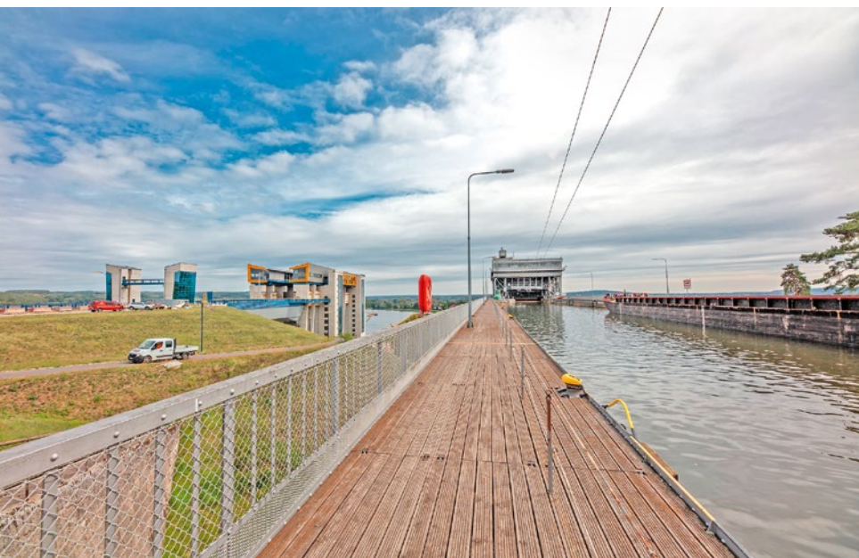
Most kanałowy do starej podnośni statków
