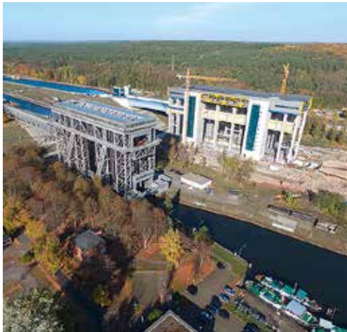
Neues und altes Hebewerk
