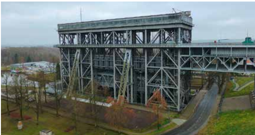
Schiffshebewerk Niederfinow – Seitenansicht von Nordwest
