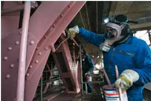
Korrosionsschutzarbeiten
