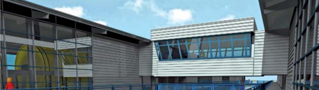
东部塔柱之间的操作台
