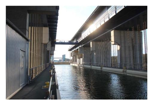
Am Nachmittag des 2. April 2020 hat der erste Hub des Troges des neuen Schiffshebewerkes Niederfinow bis auf die Höhe der oberen Kanalhaltung (36 m Hubhöhe) stattgefunden.
