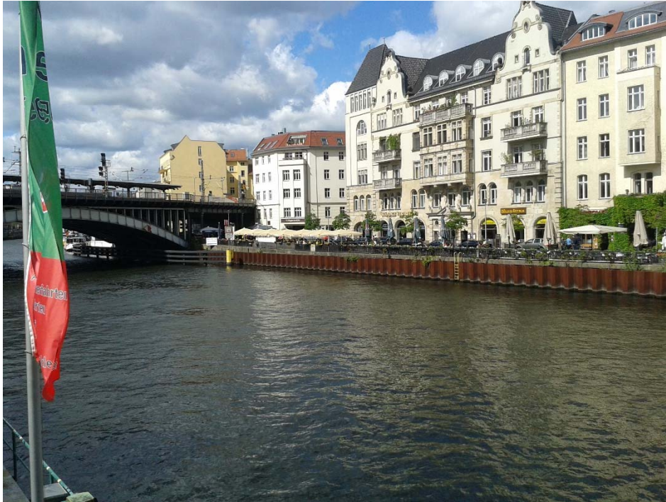
07. Mai 2015 – provisorisch gesichertes Ufer am Schiffbauer Damm
