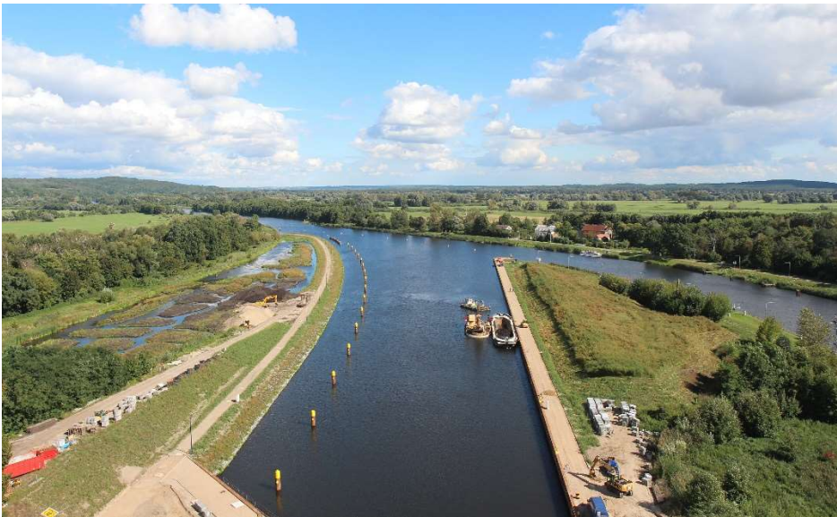
16.09.2020 – Neuer Unterer Vorhafen Niederfinow nach Fertigstellung
