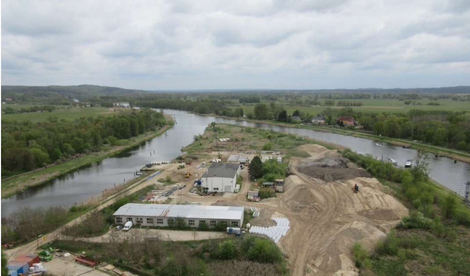
04.05.2016 – Neuer Unterer Vorhafen Niederfinow, Baufeld vor Baubeginn
