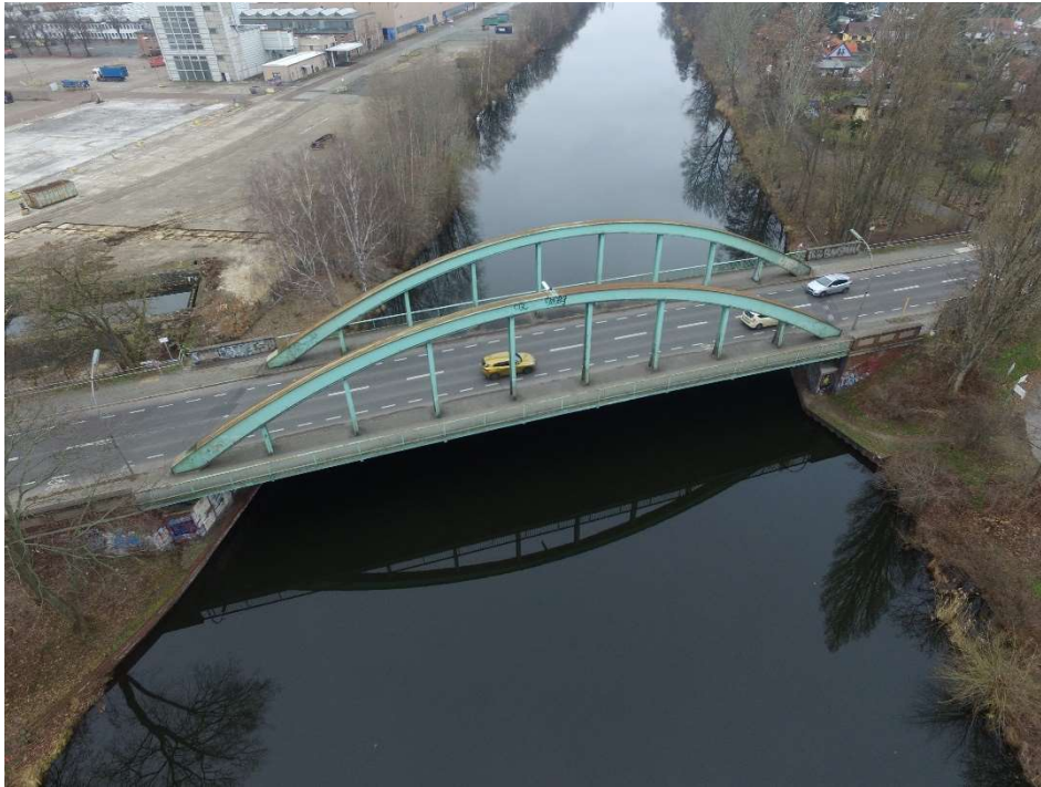
07.02.2020 – Tegeler Brücke vor Baubeginn
