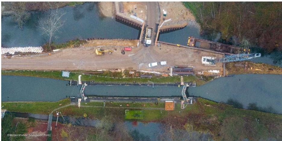
25.11.2020 – Bauzustand alte Schleuse Steinhavel
