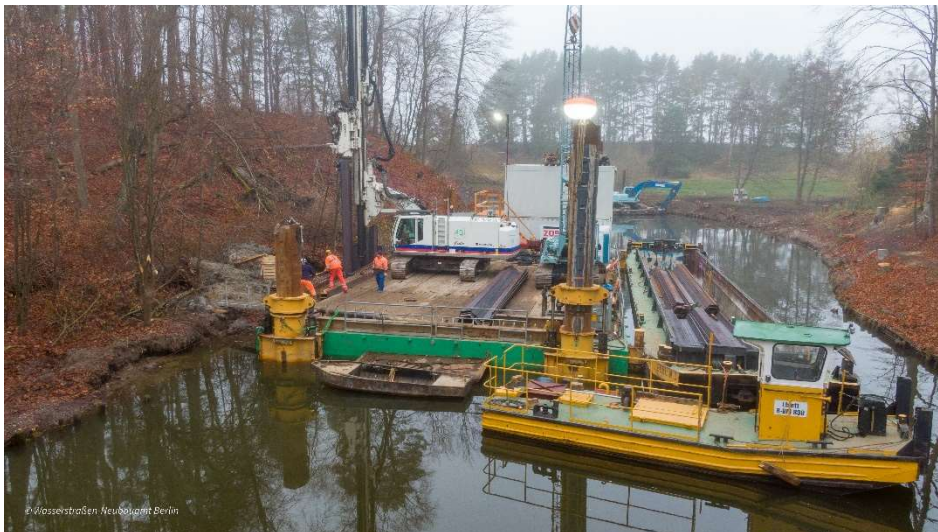
25.11.2020 - Gerätekomplex „Flexifloat“ beim Einbau einer Uferspundwand für die Wartestelle im oberen Vorhafen
