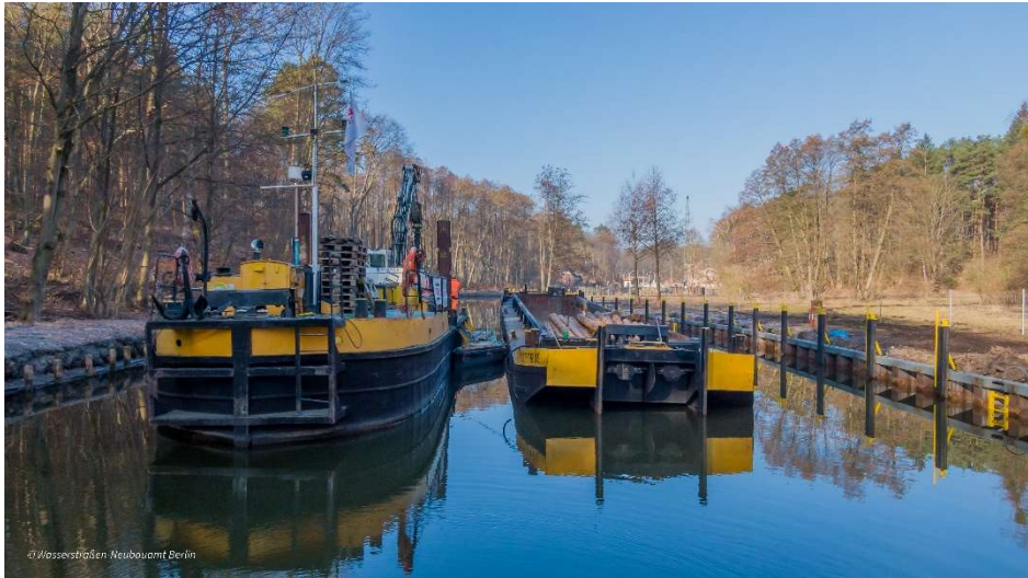
05.03.2021 - Gerätekomplex Schwimmgreifer beim Einbau einer Ufersicherung im unteren Vorhafen
