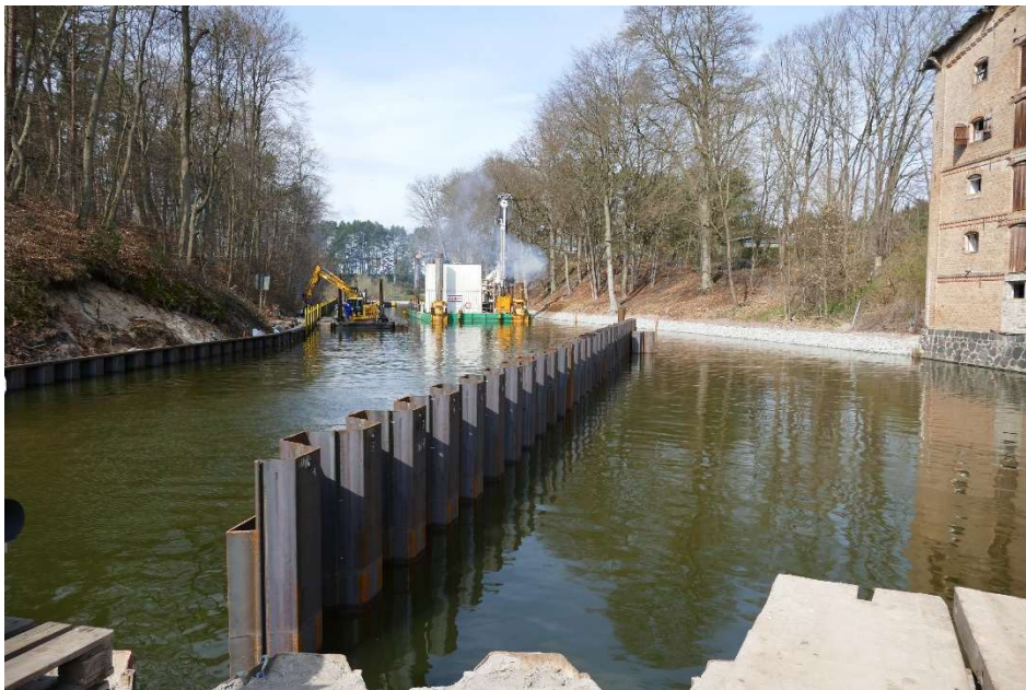
16.04.2021 – Bauzustand mit eingebauter südlichen Begrenzungsspundwand für die neue Fischaufstiegsanlage
