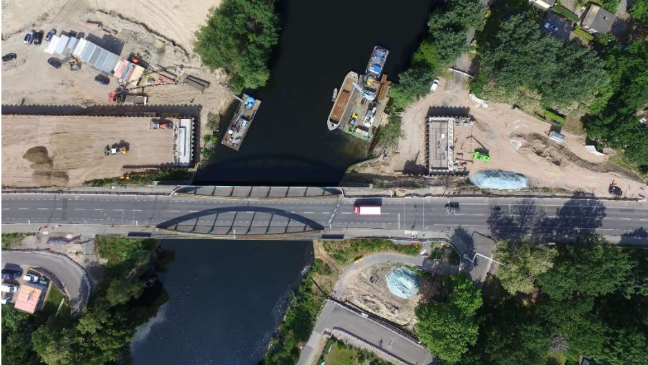
11.06.2021 – Tegeler Brücke, Baufeld (links die Montagefläche für die Behelfsbrücke)
