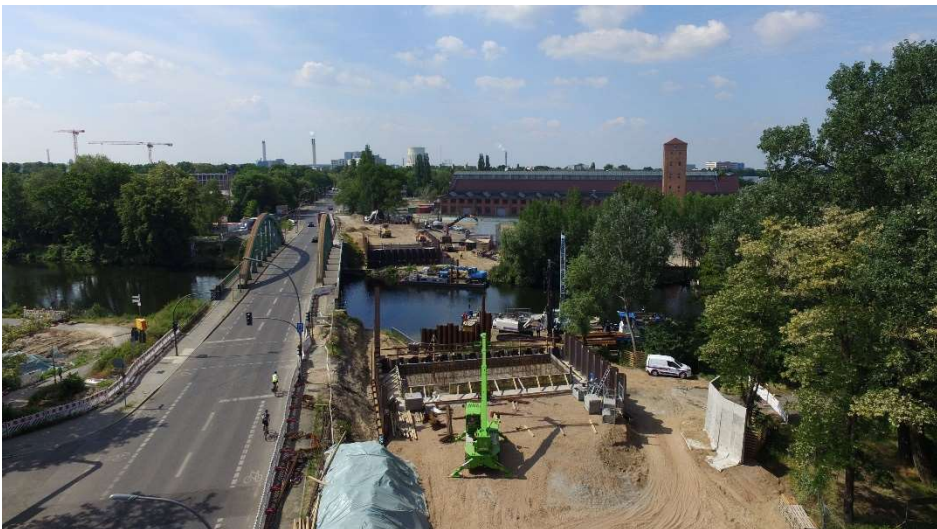
11.06.2021 – Tegeler Brücke, Baufeld (Behelfsbrückenwiderlager Nord, im Bau)
